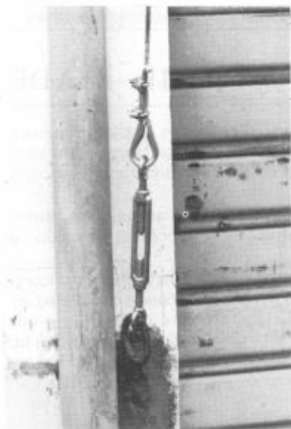
Fig. 4 I tenditori a vite sono estremamente funzionali per mettere in opera tutta la tiranteria del traliccio. Osservare la corretta utilizzazione dei serracavo e della redancia
